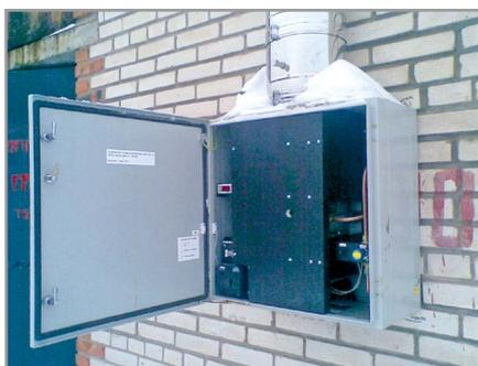
Рис. 14. Генератор ТЭГ-15 на газораспределительном пункте
