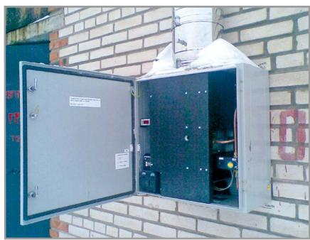
**Рис.14. Генератор ТЭГ-15 на газораспределительном пункте**
